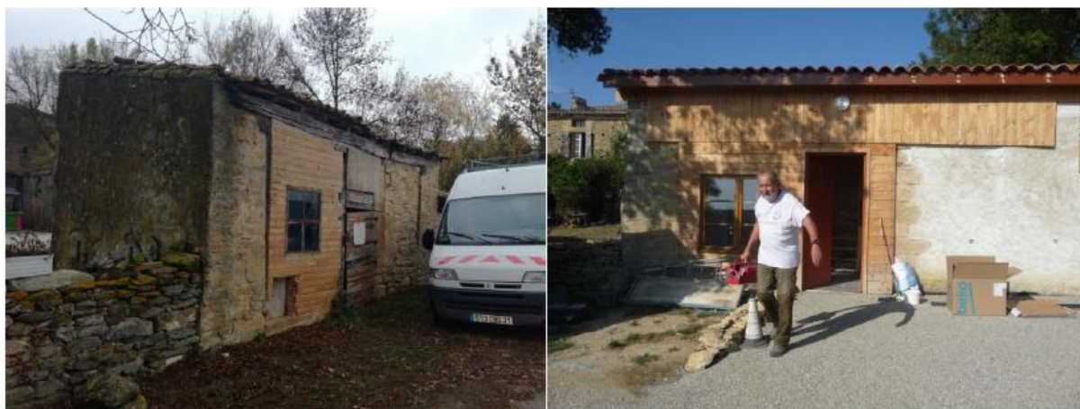
Le bâtiment avant et après travaux
